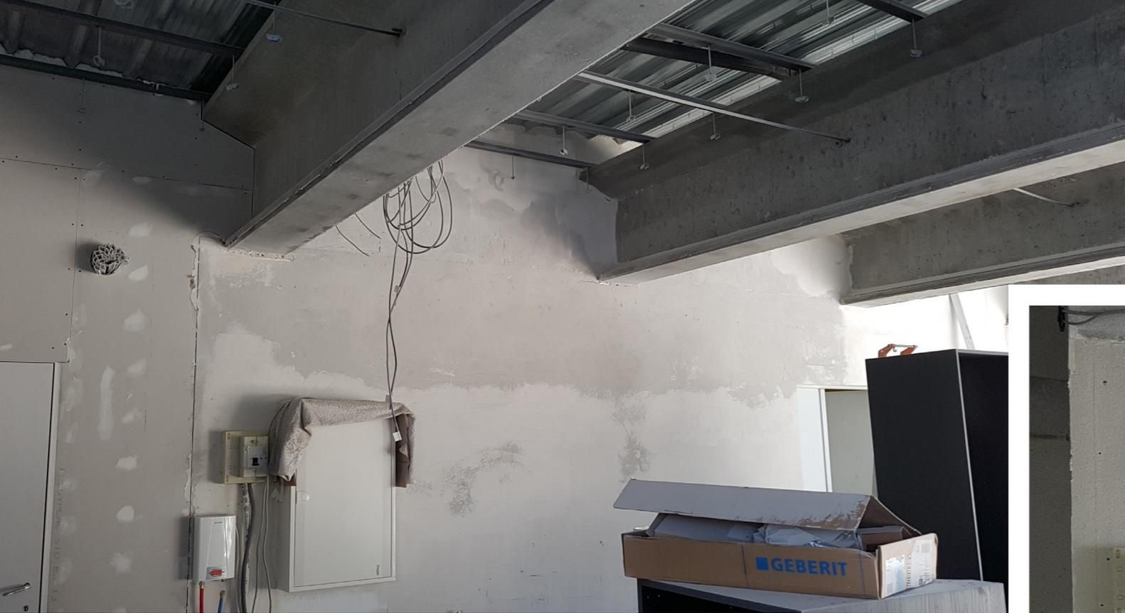
On rentre dans la phase de redressage des murs et lissage. Ça a été ma partie préférée...
